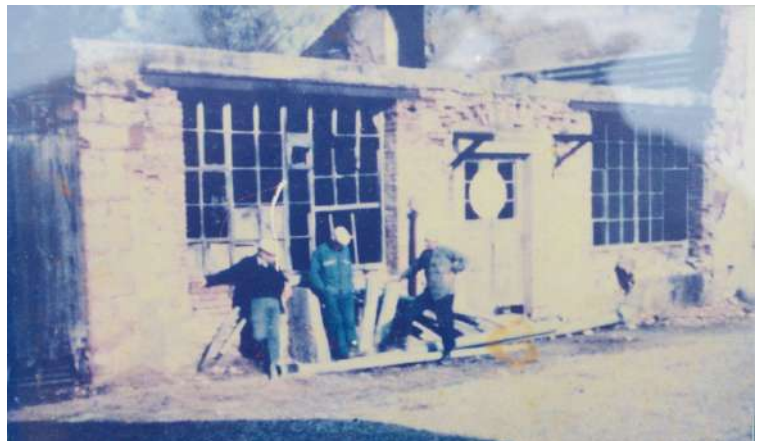
Le bâtiment délabré de la salle des machines avant les travaux de rénovation de 1982. Extrait d'une photo exposée à l'intérieur du restaurant.
