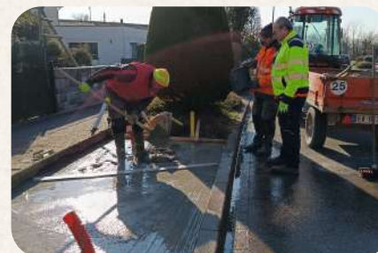
Réalisation d'une dalle en béton pour la silhouette du char
