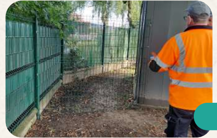
Mise en place d'un grillage à l'école maternelle
