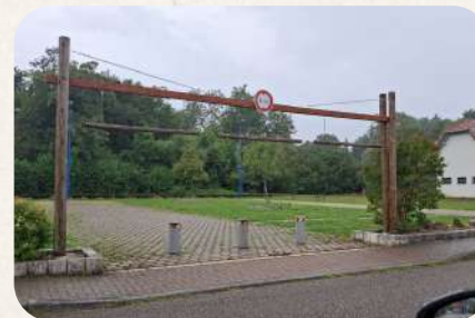
Remplacement de 2 poutres au parking covoiturage
